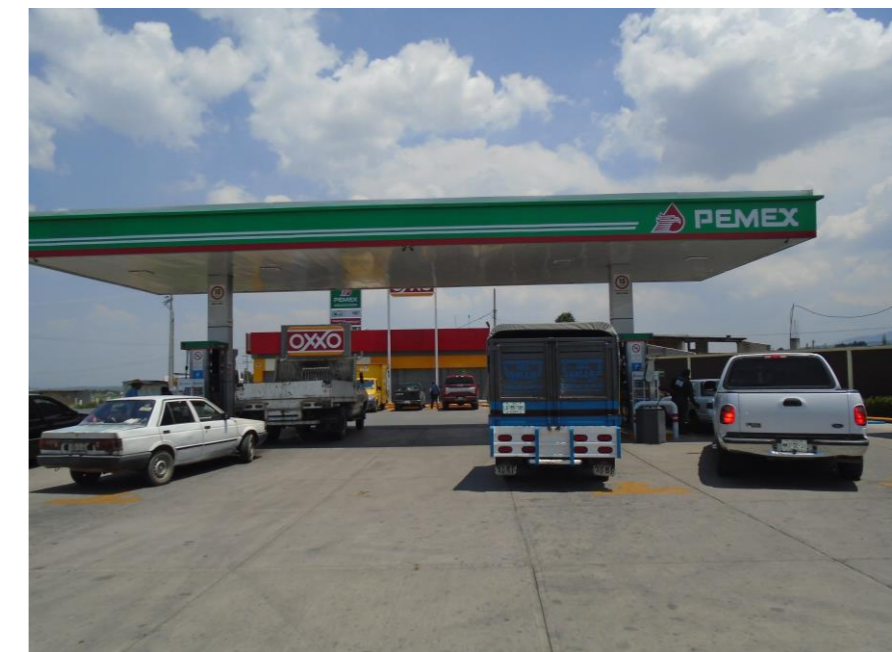
ESTACION DE SERVICIO JALTEPEC
