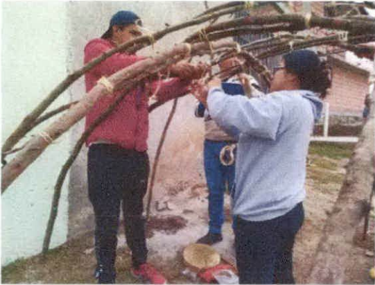
Construcción del temazcal en San Francisco
